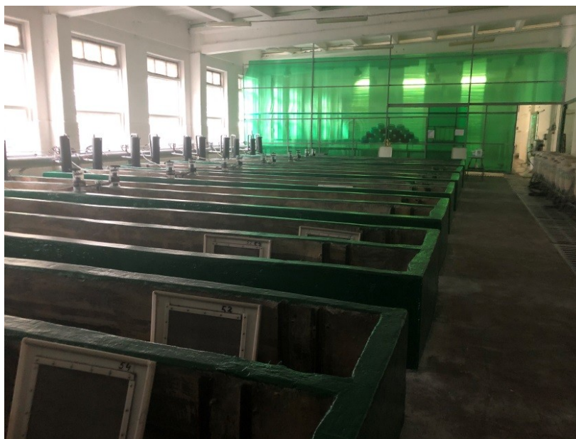
Рисунок 4 – Бассейновый участок с бетонными бассейнами
