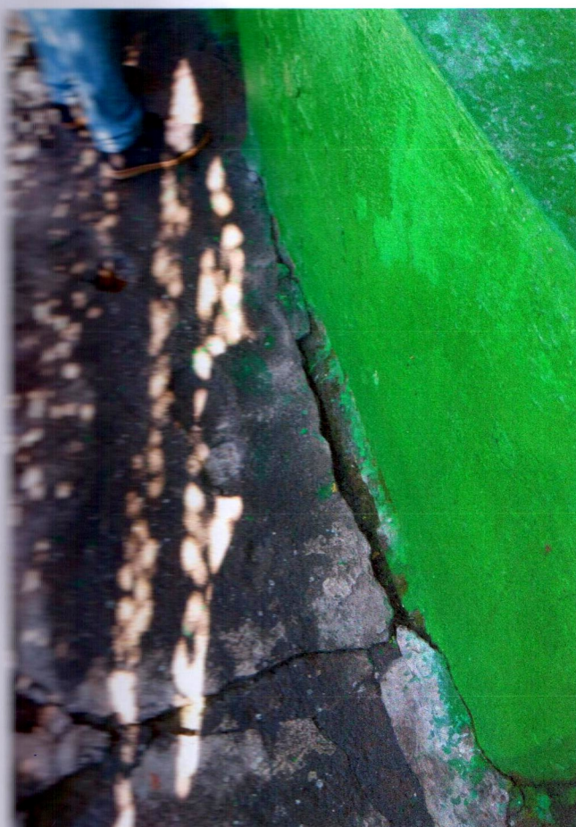
Литер «А», производственные помещения
