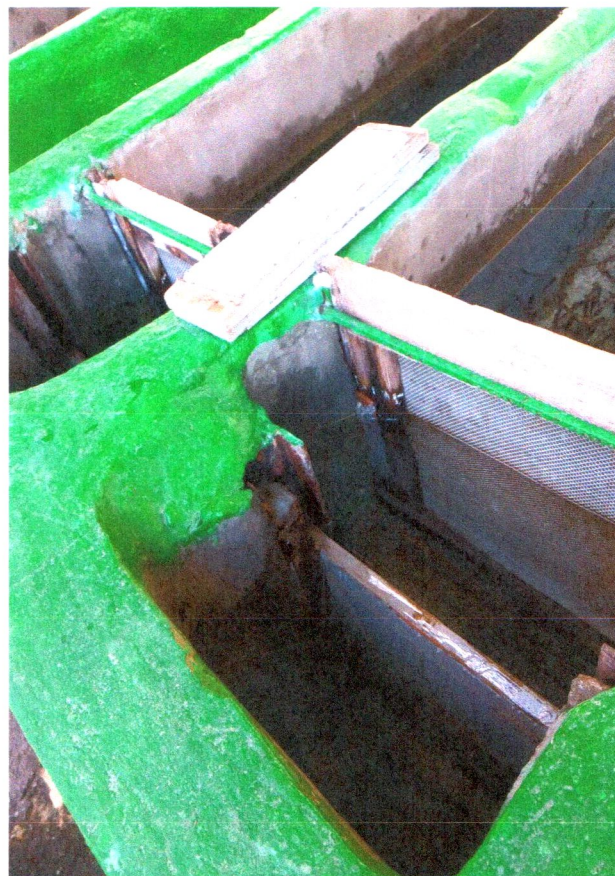
Литер «А», производственные помещения
