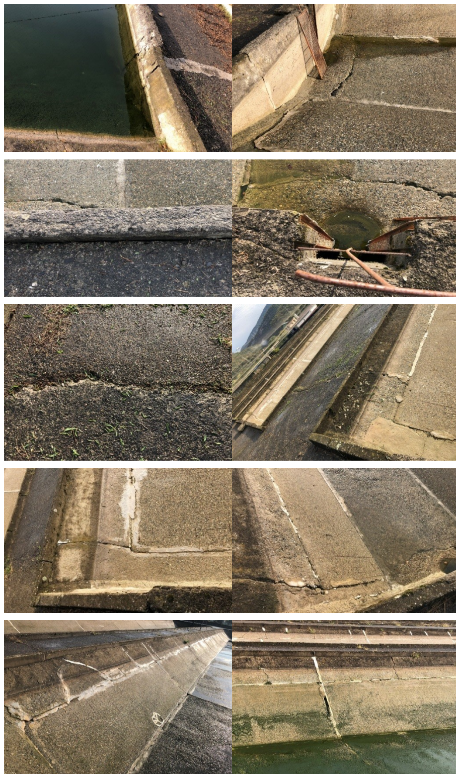
Рисунок 19 – Износ конструктивных элементов участка
