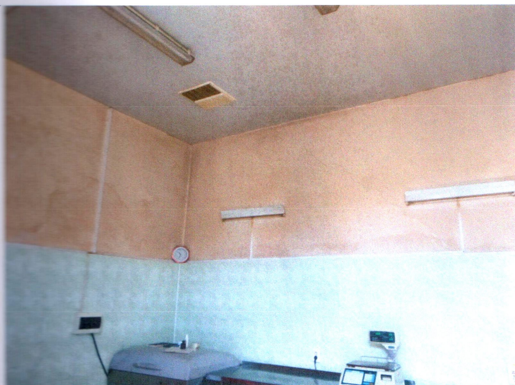
Литер «А», производственные помещения
