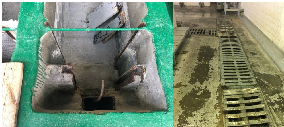
Рисунок 7 – Донный водослив
