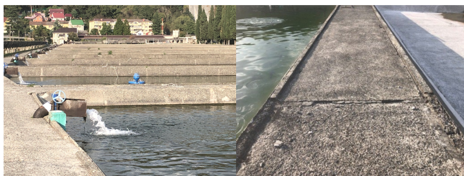
Рисунок 12 – Железобетонные пруды нагульного участка
