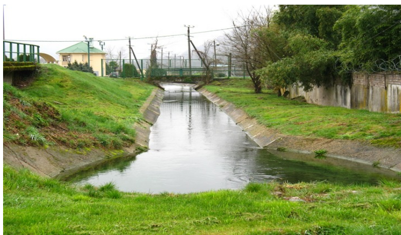
Рисунок 55 – Магистральный сброс-коллектор
