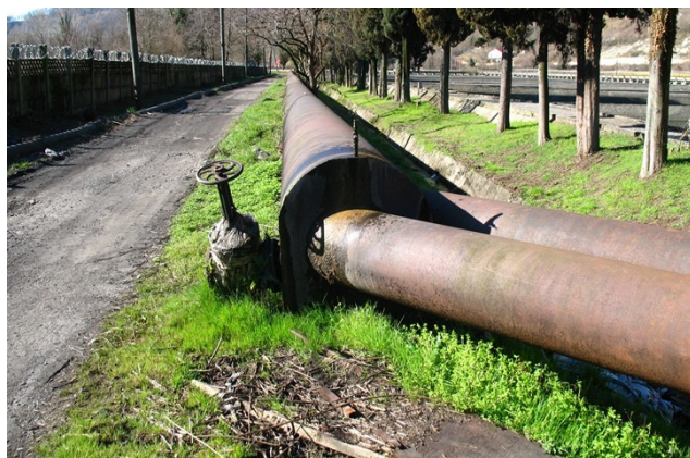
Рисунок 56 – Напорный трубопровод
