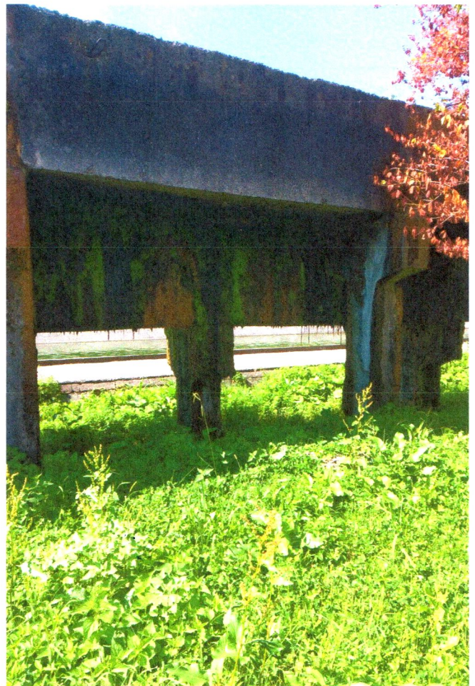
Литер “VI” распределительный канал
