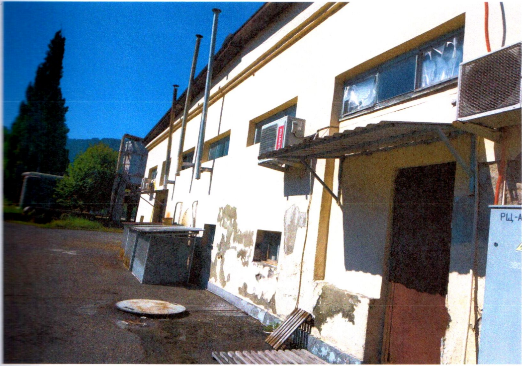
Литер «А», производственные помещения
