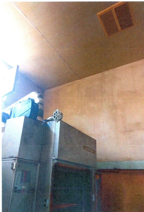
Литер «А», производственные помещения
