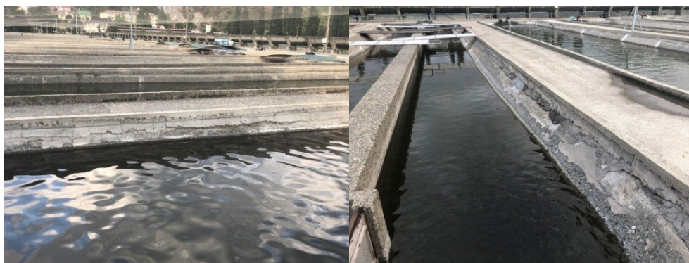
Рисунок 10 – Железобетонные пруды выростного участка
