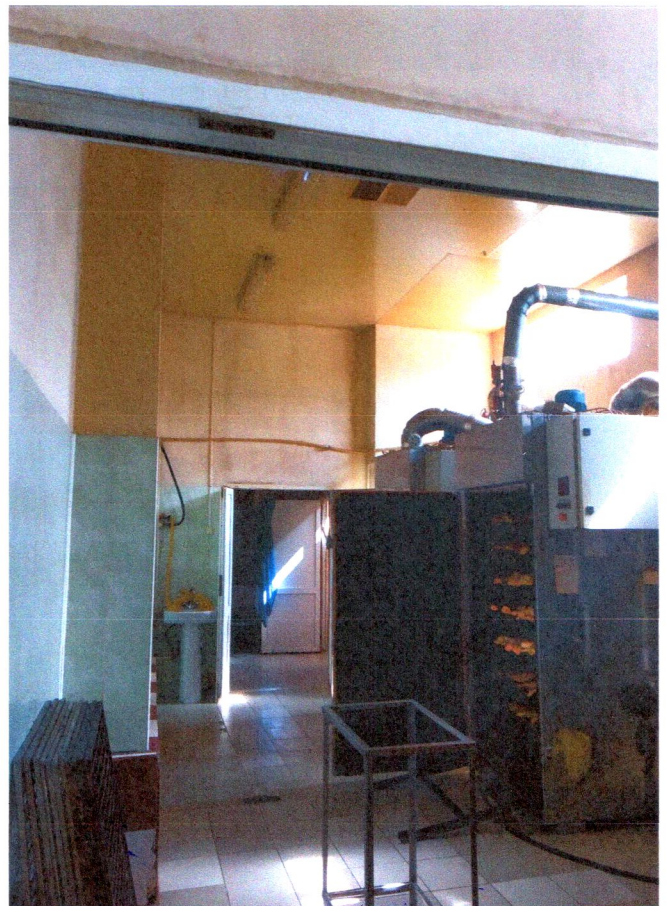
Литер «А», производственные помещения
