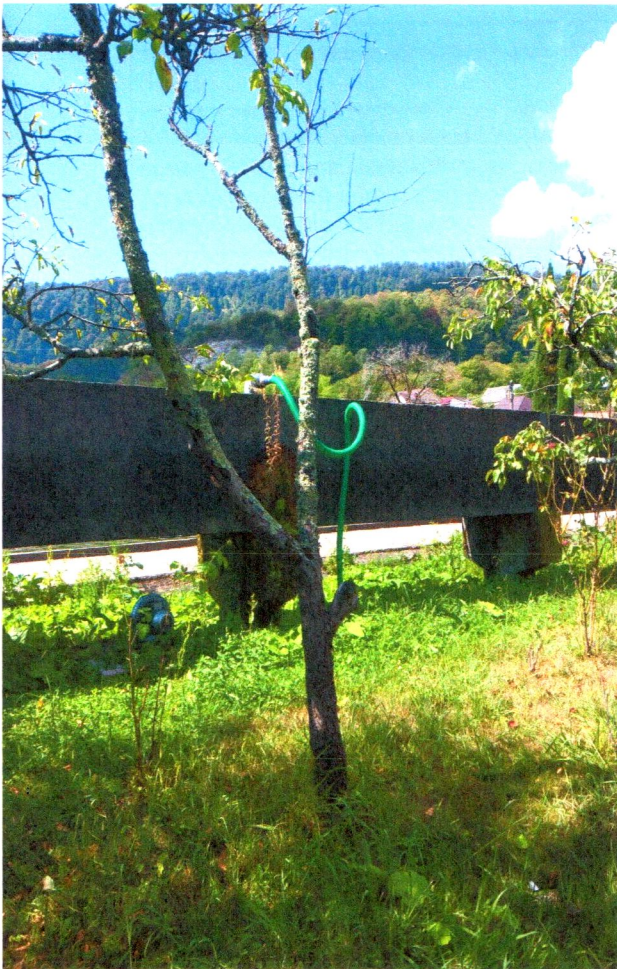
Литер “VI” распределительный канал
