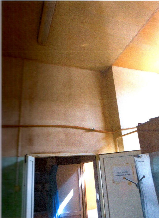
Литер «А», производственные помещения
