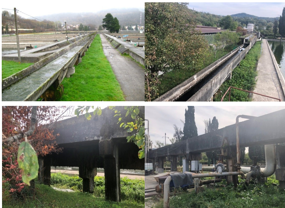
Рисунок 62 – Распределительный канал
