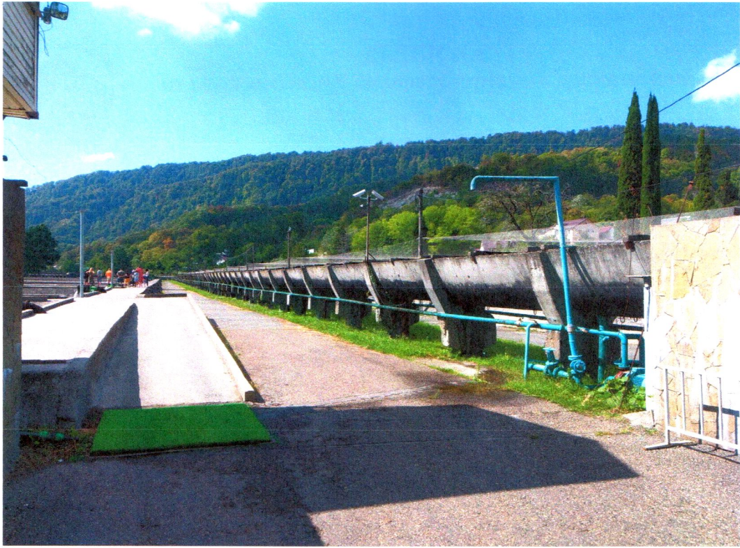
Литер “VI” распределительный канал
