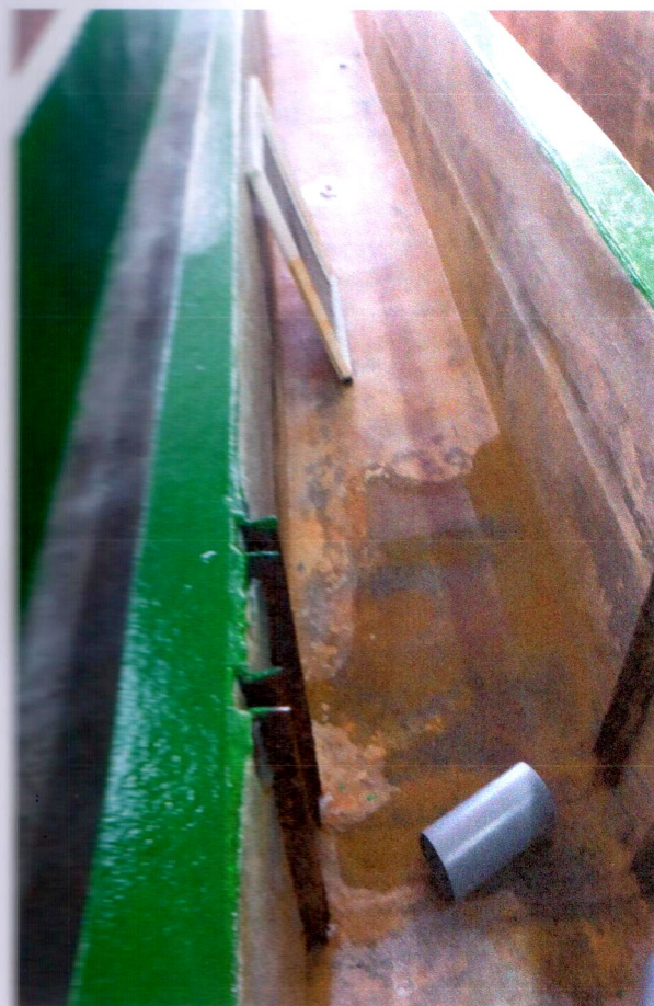
Литер «А», производственные помещения
