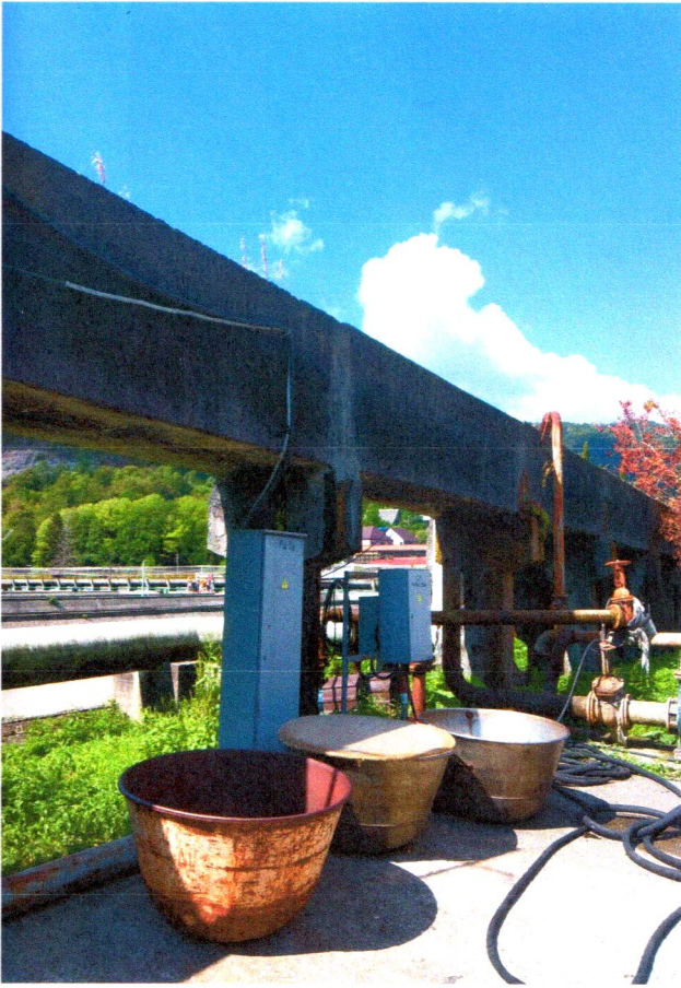
Литер "VI" распределительный канал
