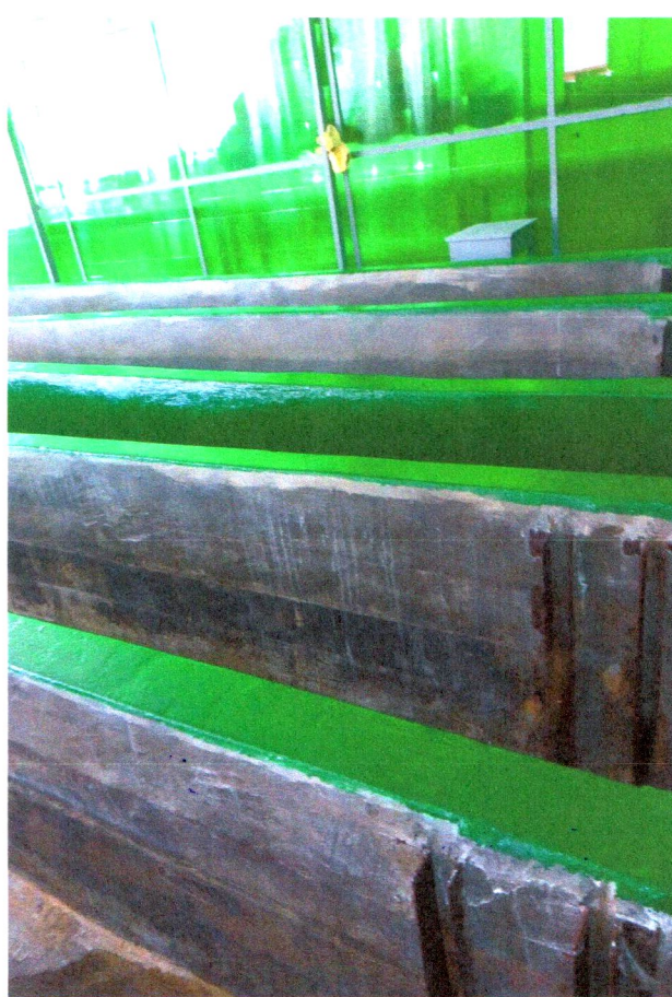
Литер «А», производственные помещения
