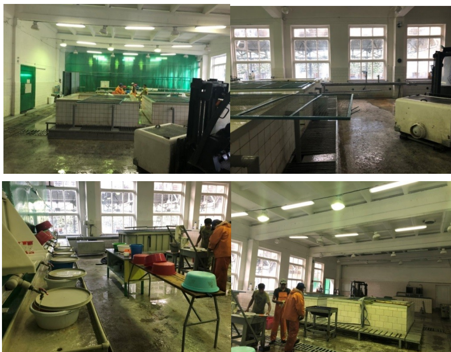
Рисунок 1 – Двойные бетонные бассейны нерестового цеха
