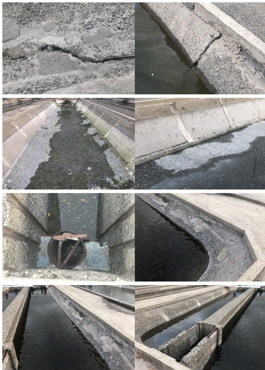
Рисунок 11 – Износ конструктивных элементов выростного участка
