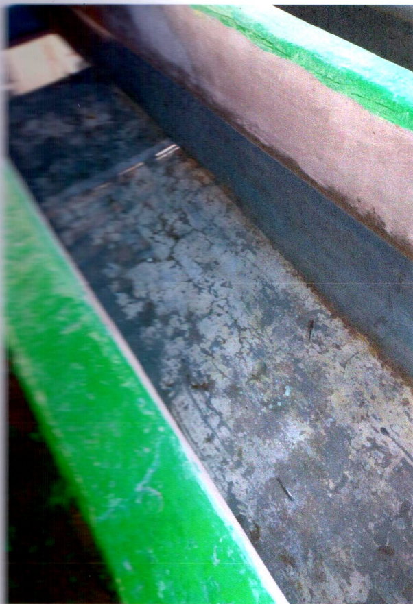
Литер «А», производственные помещения
