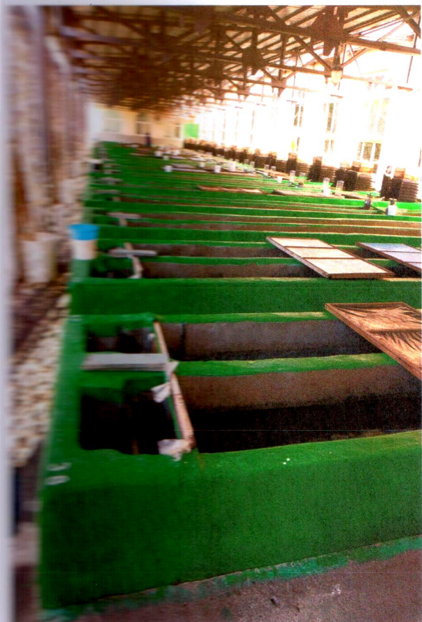
Литер «А», производственные помещения
