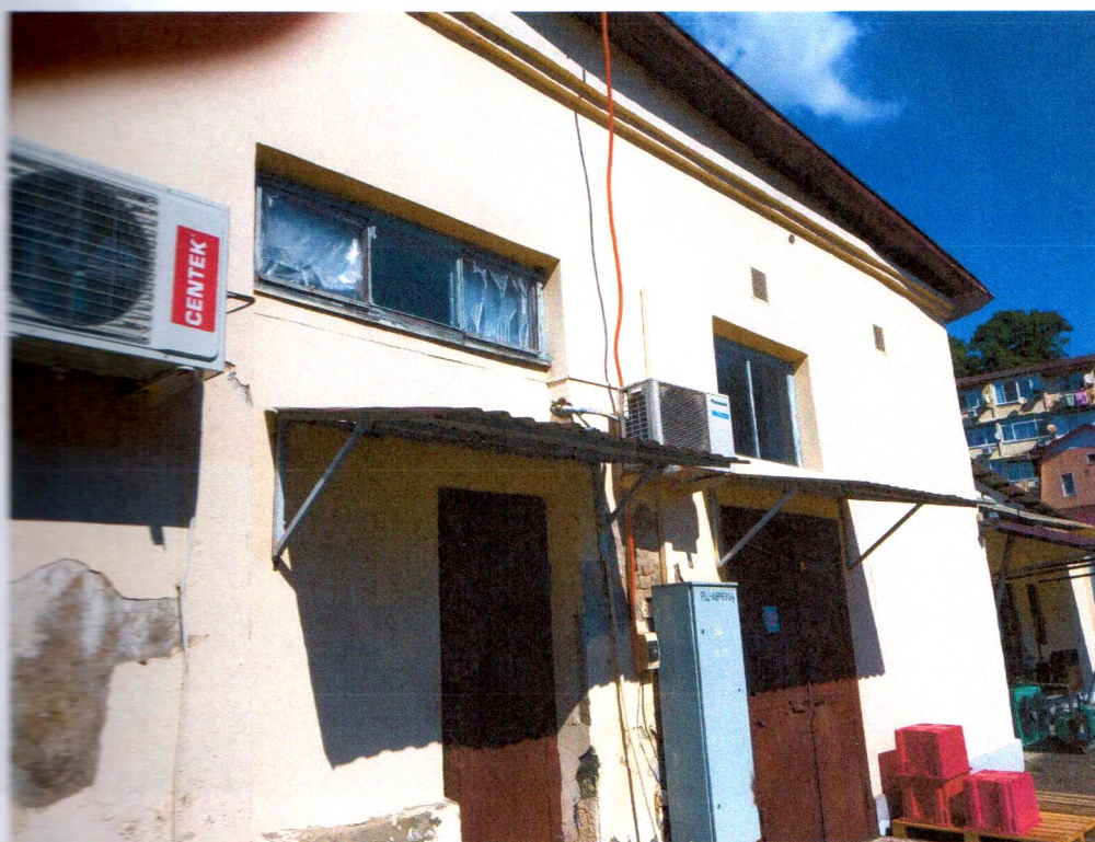
Литер «А», производственные помещения
